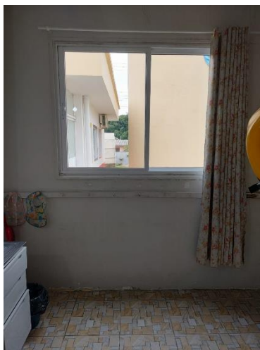
Imagem: Local a ser demolido para acesso a sala de aula
