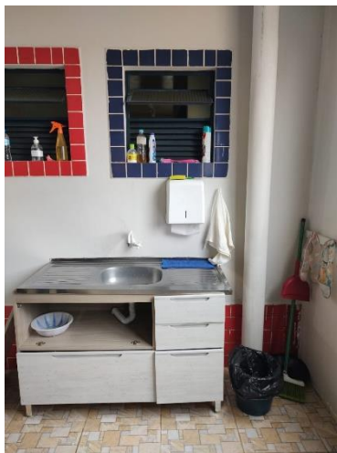
Imagem: Local a ser demolido para acesso ao banheiro
