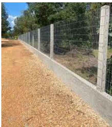
Figura 3: Alvenaria de blocos de concreto.
