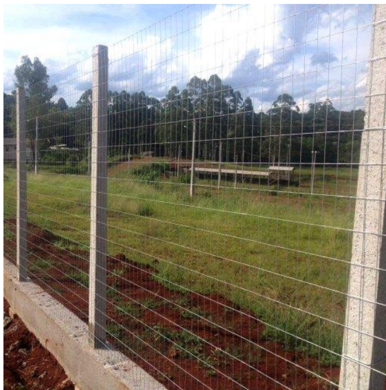
Figura 1: Modelo de mourões e tela a serem utilizados.
