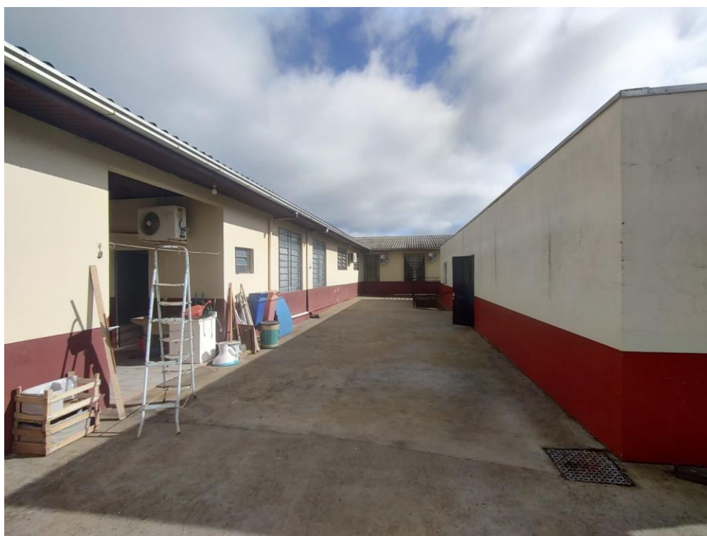
Imagem: Local da execução da cobertura de ligação entre os prédios.
