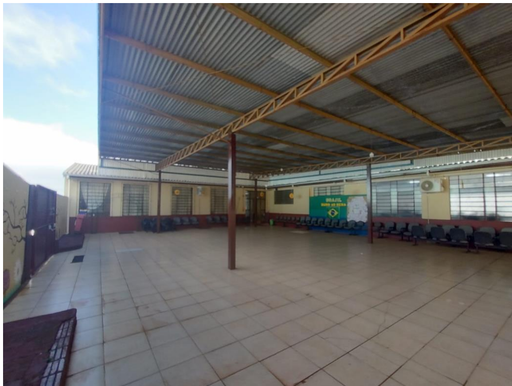
Imagem: Cobertura Existente.
