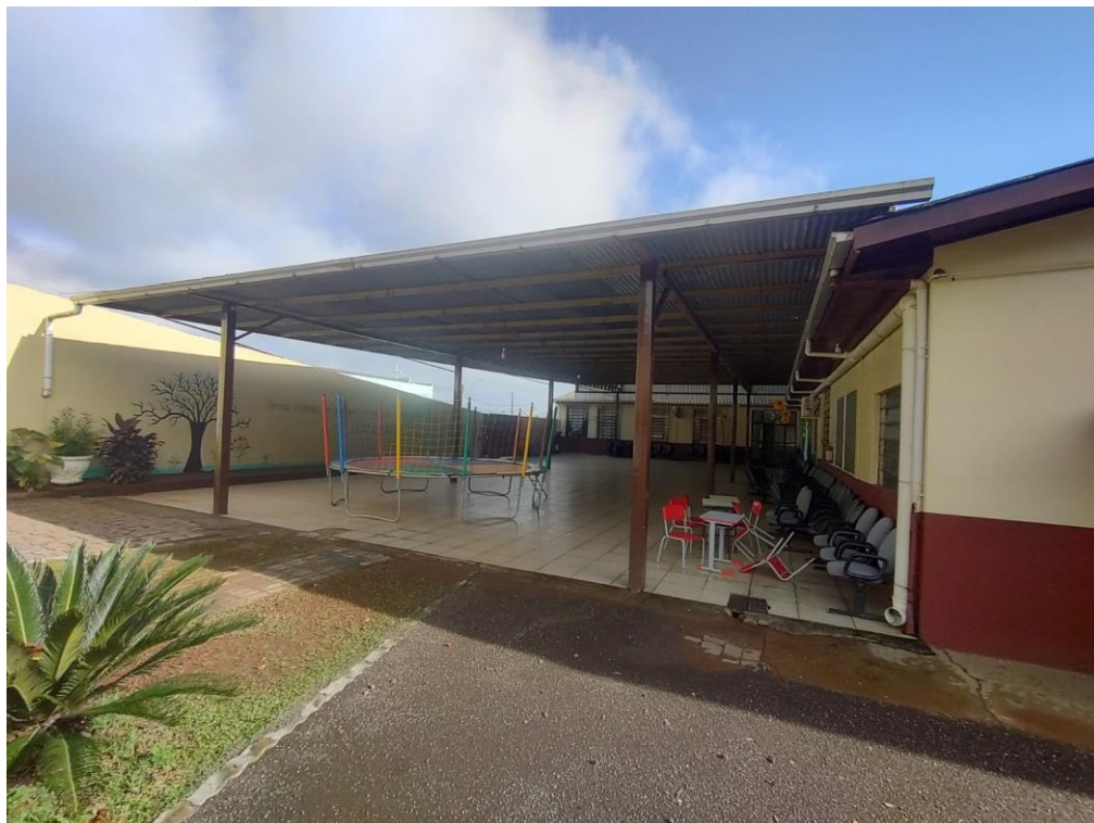
Imagem: Cobertura Existente.
